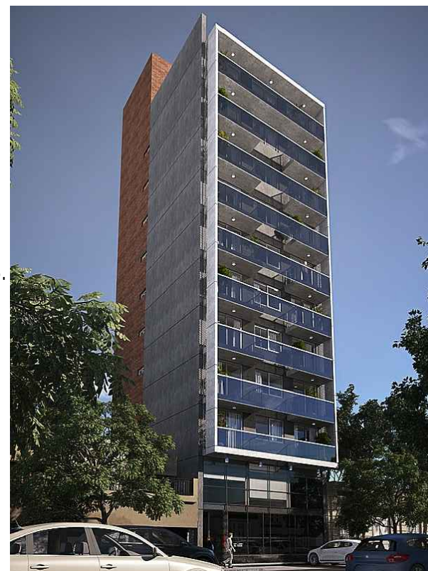
OVIDIO LAGOS 628 - FACHADA aproximada
